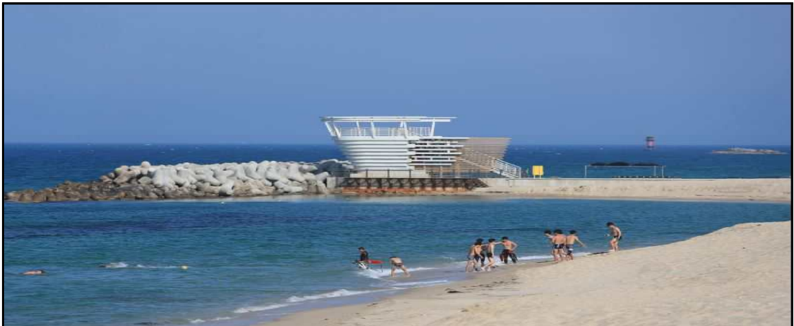
해중공원 레저전용존 조성사업 육상시설
